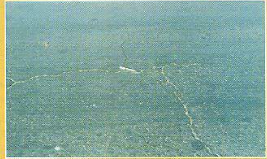
صورة «٤-أ» - التشققات في الطريق الدائري جنوب مدينة العريش
