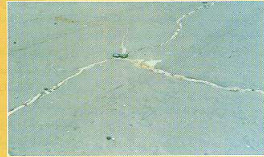
صورة «٤-ب» - التشققات في طريق فرعى من الطريق الرئيسي في رمادة
