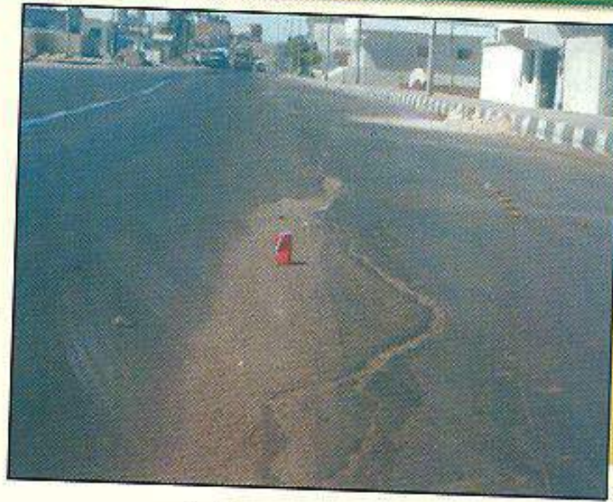
صورة «٢» توضح إحدى المناطق المتشققة والهابطة بطريق قنطرة القصير عند التقاءه بالطريق الساحلي عند وادي العسبيحي فاظفرا ناحية الشرق.
